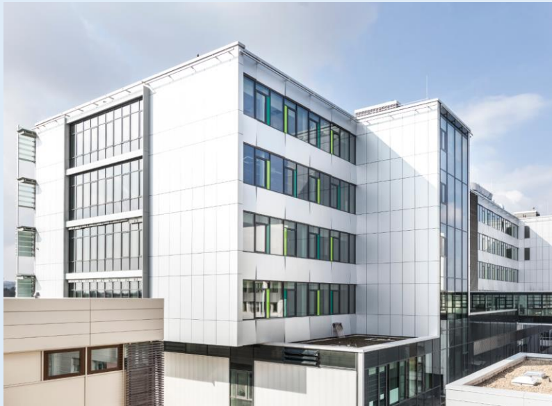
New technical center "Gebäude D" in Stuttgart
